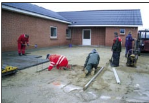
Efter meget arbejde - noget i regn og kulde - kom de sidste detaljer på plads ved byggeriet af Vinding Forsamlingshus. Foto Kim Have.
